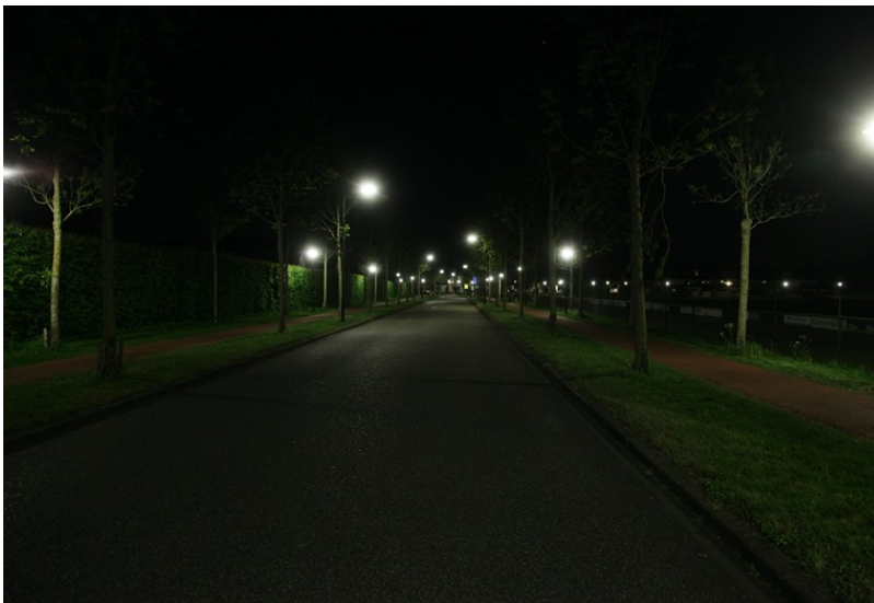
Foto: Bommel, straat met veel licht. Hier kan op moment van vervanging licht verminderd worden.
