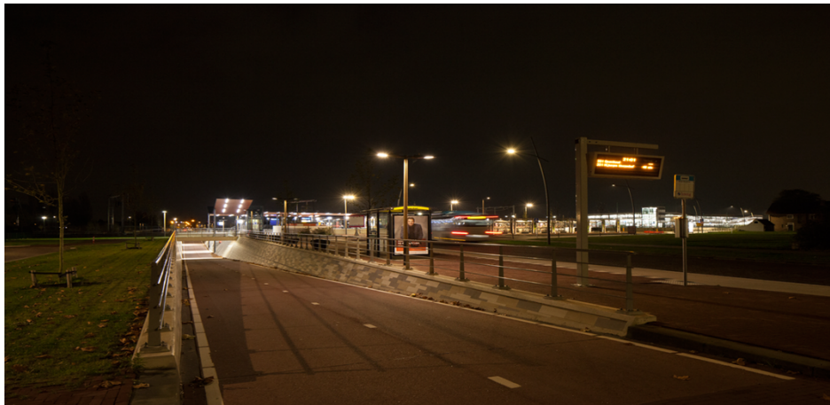
Foto: Station Elst. ProRail stelt hoge eisen aan de verlichting op en rond de stations. Het staat de hele avond en nacht volop in het licht. Daarbuiten lijkt het heel donker doordat daar een 'normale' hoeveelheid licht staat.
