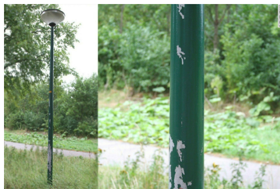
Foto CROW: dekkingsgraad coating \geq 95\% per lichtmast
