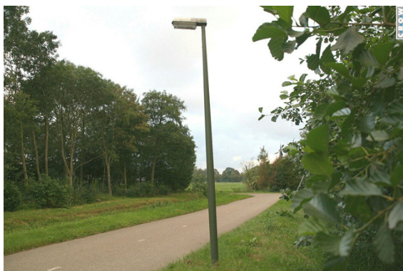
Foto CROW: scheefstaand \leq 3 graden per lichtmast
