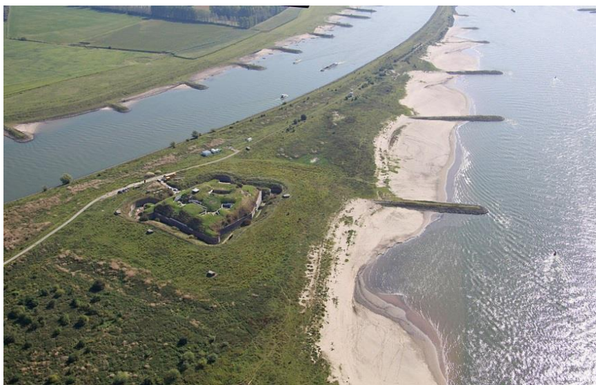
Zicht op Fort Pannerden
